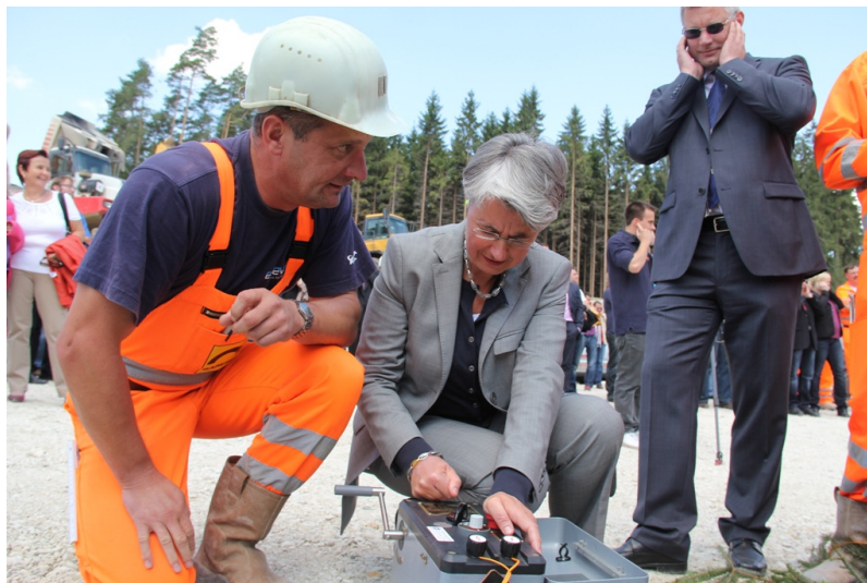
Foto 1: Die Sprengung gelingt mit Tunnelpatin Barbara Daumiller-Zeil und Vortriebspolier Olaf Leischke
