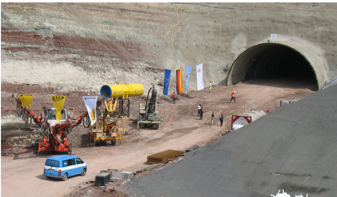
(Bild 1: Eingang Tunnel Rennberg)
